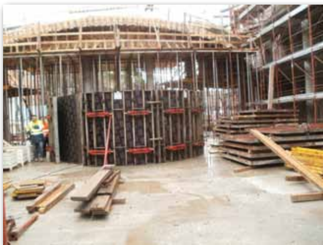
Foto n° 6 - Cassero per il campanile e, sullo sfondo, il pronao
