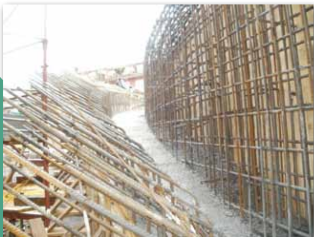
Foto n° 7 - Armatura della trave di coronamento del pronao
