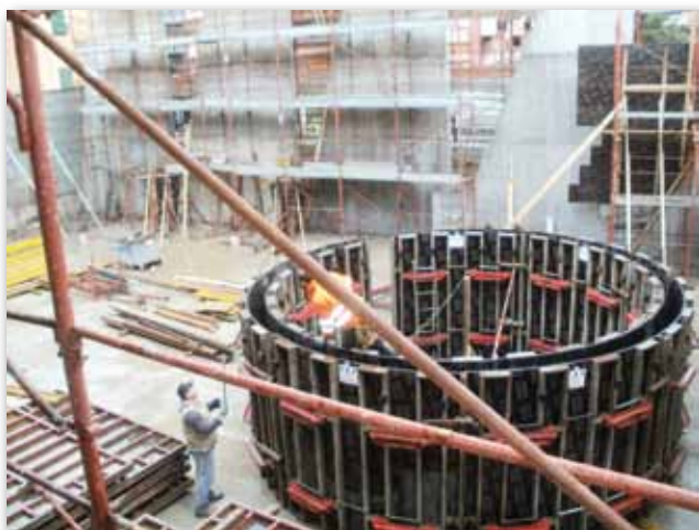
Foto n° 2 - Cassero per il campanile
